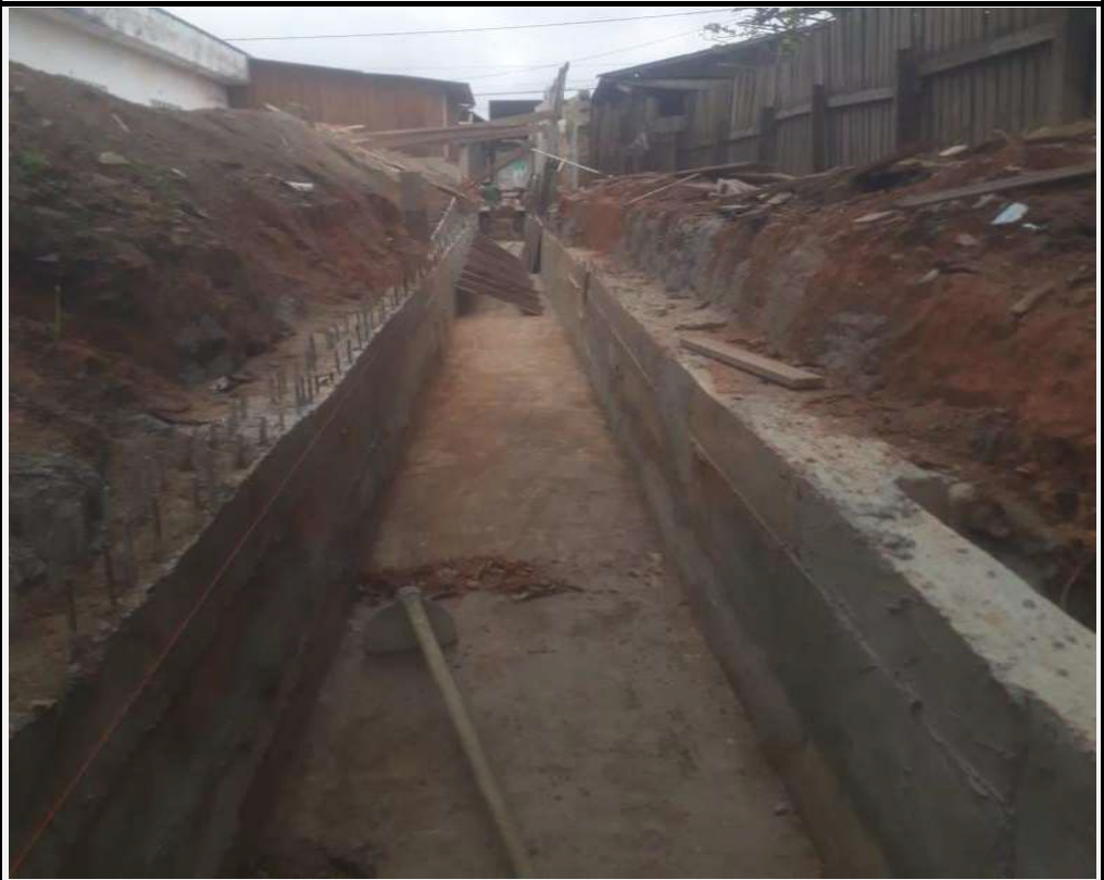
Imagem 3 - Serviço de desforma e limpeza do trecho 2 da canaleta em concreto armad
