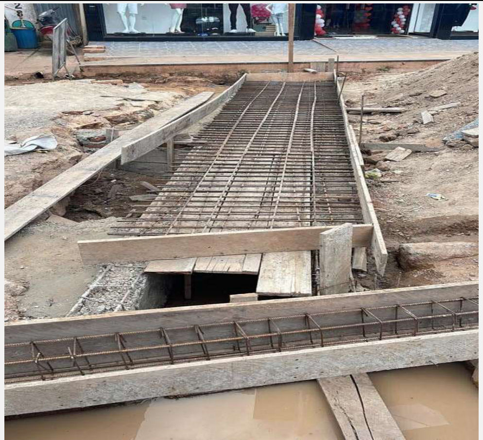
Imagem 5 - Serviço de confecção de forma em madeira e fixação das armaduras de aço do trecho 1 na avenida Brigadeiro Haroldo C. Velos
