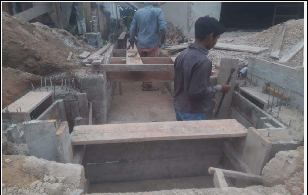
Imagem 4 - Serviço de confecção de forma da tampa do trecho 2 da canaleta em concreto armado
