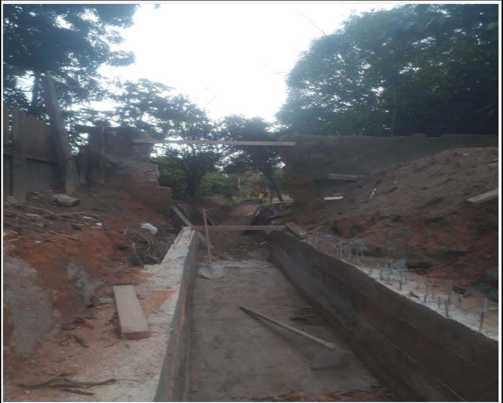
Imagem 2 - Serviço de desforma do trecho 2 e escavação manual do trecho 3.
