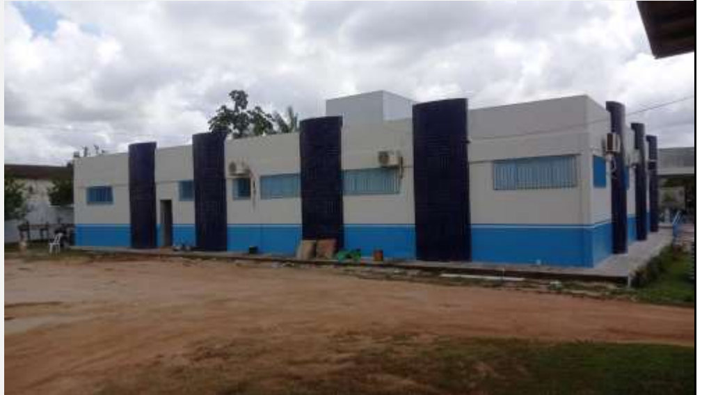
Imagem 3– Área externa recebendo pintura.
