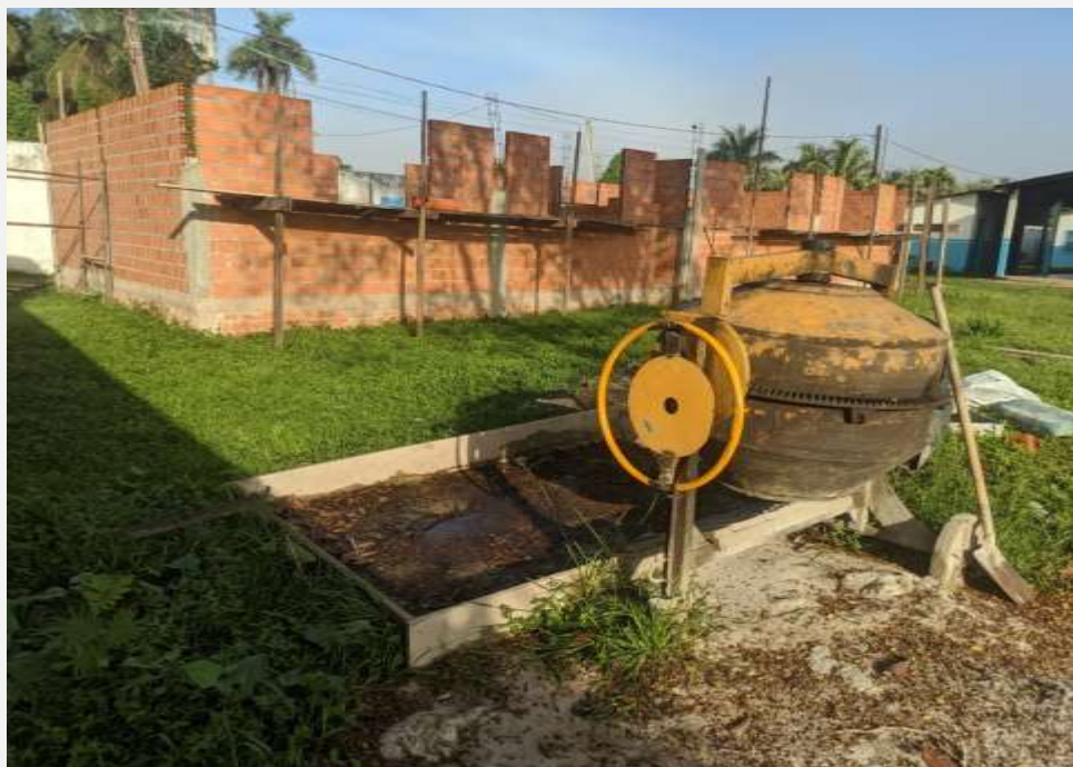
Imagem 3–VISTA EXTERNA DA OBRA.
