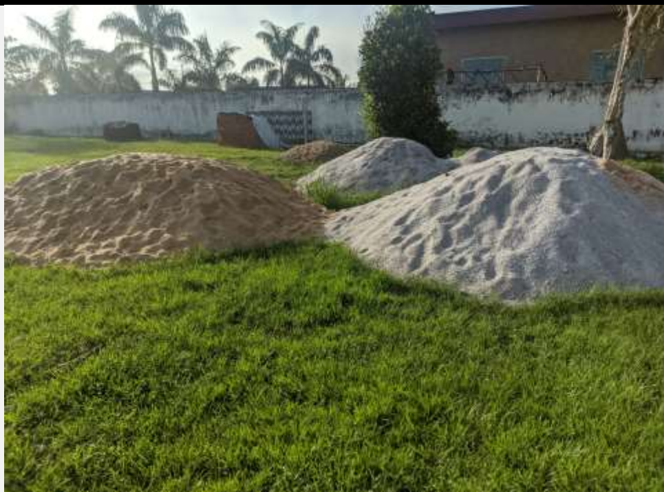
Imagem 2 – AGREGADOS NO CANTEIRO DE OBRA.
