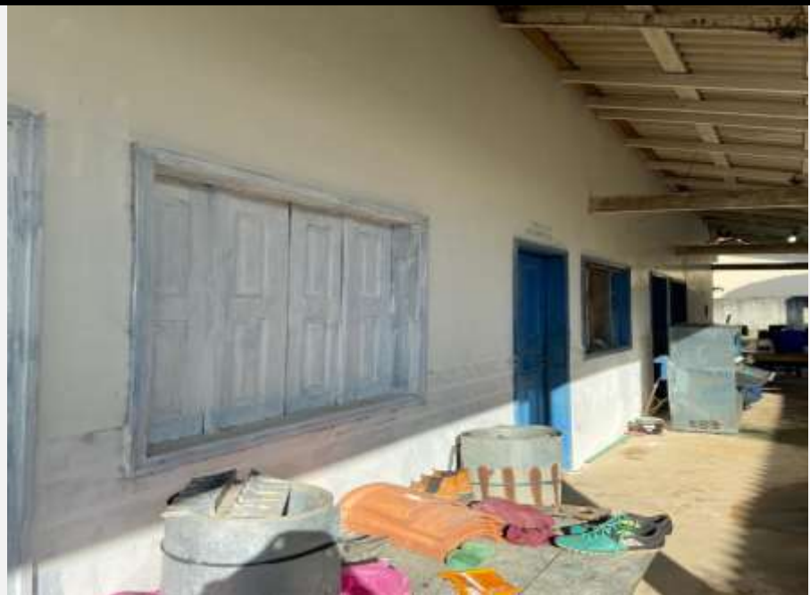
Imagem 4– primeira demão de pintura já executado.
