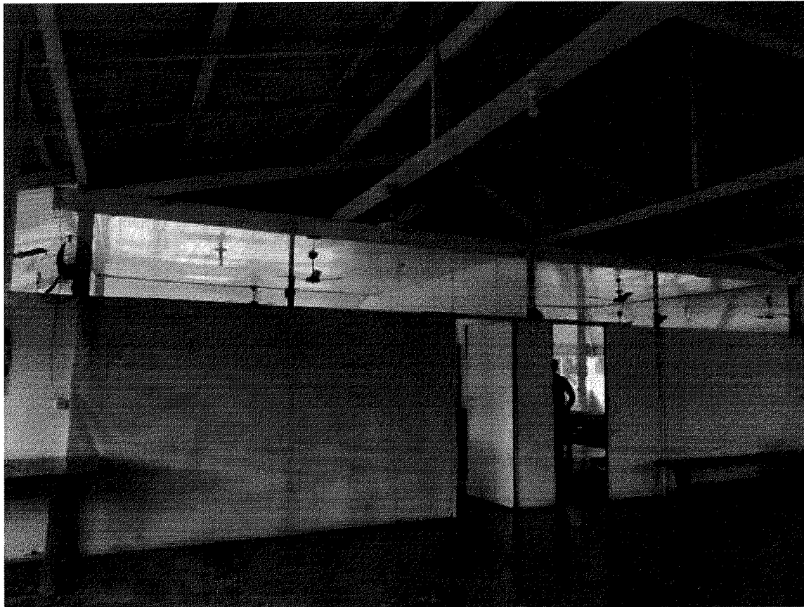
Divisórias que precisam de substituição. Em 22/09/2021.
