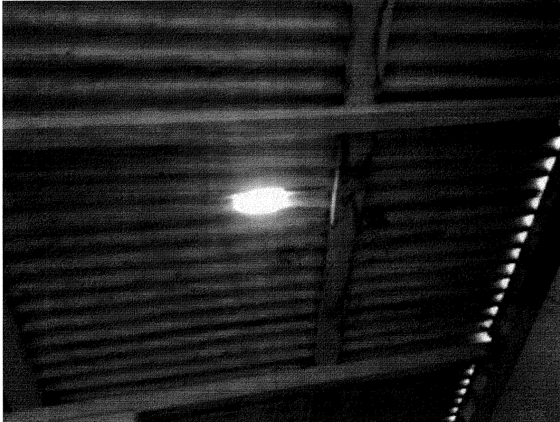
Cobertura apresentando necessidade de reparos. Em 22/09/2021.
