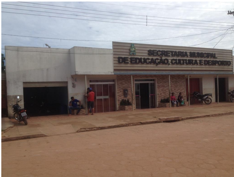
Vista frontal da fachada da edificação.
