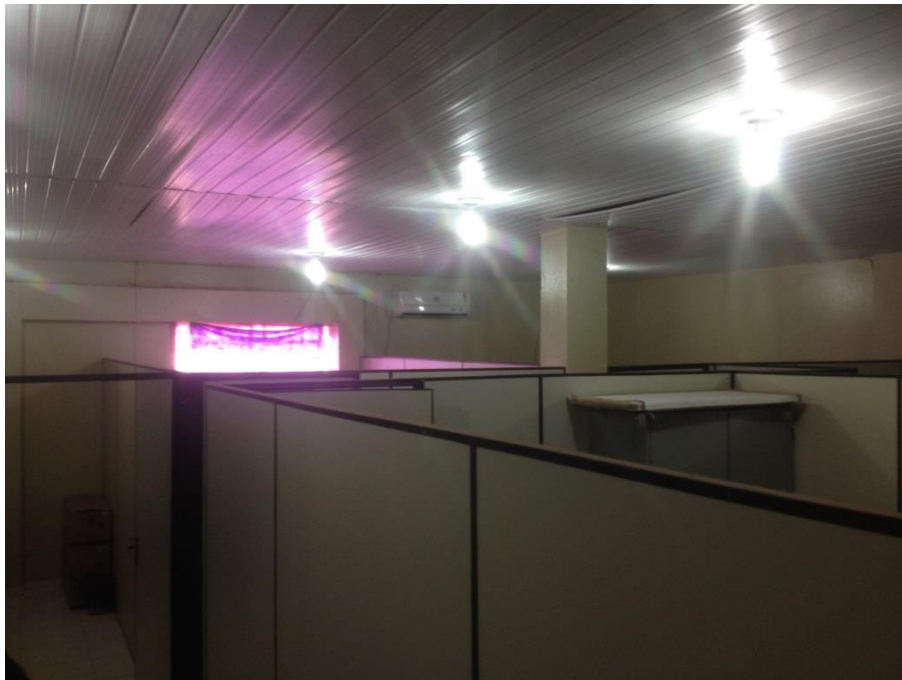
Divisões internas existentes na edificação.
