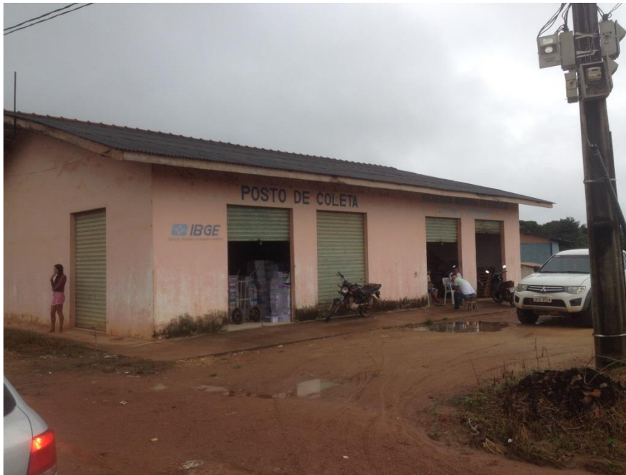
Vista frontal da fachada da edificação.
