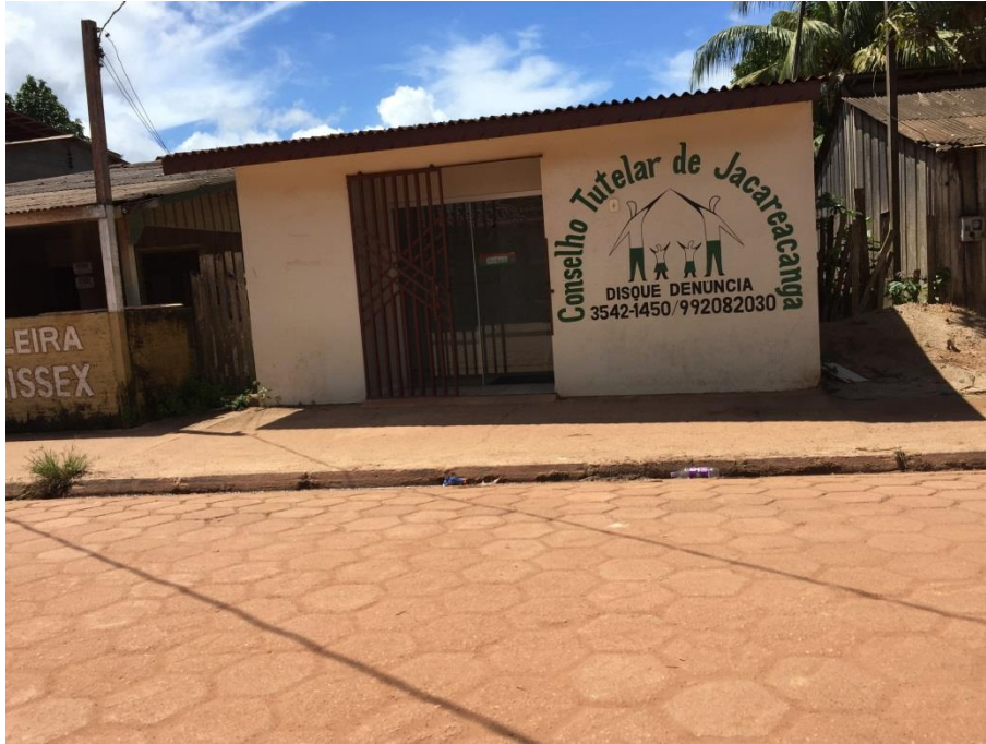
Vista Frontal da fachada da edificação.
